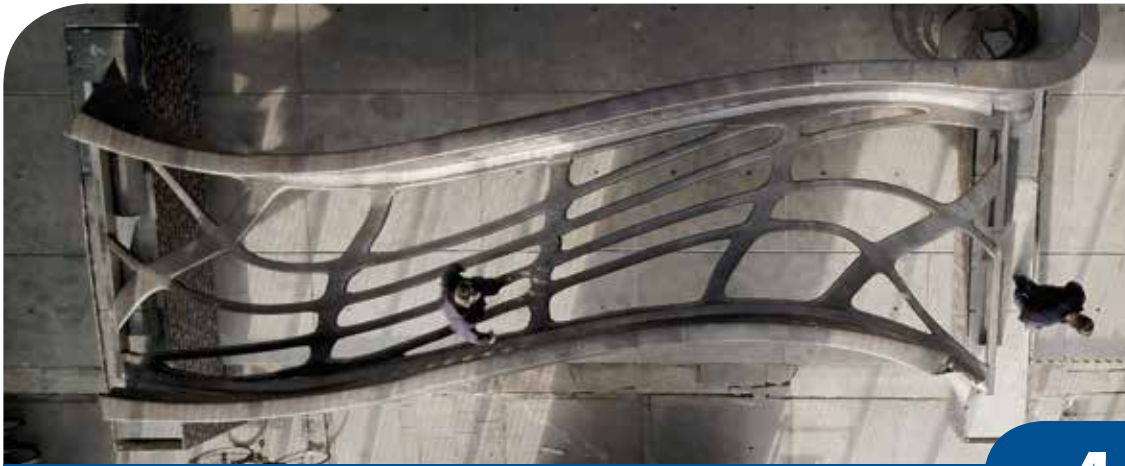
3D-geprinte brug met flexibele epoxyslijtlaag
